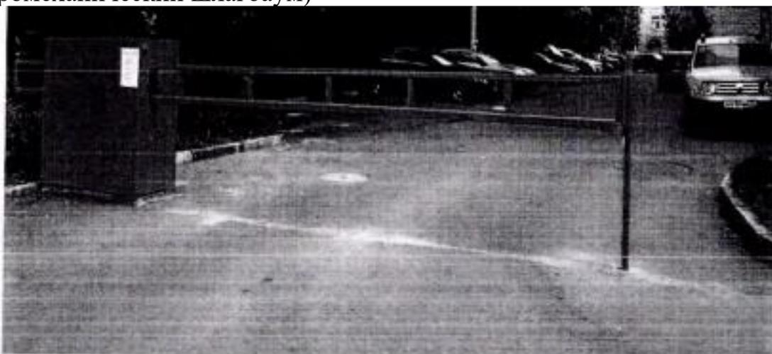
Размеры шлагбаума: Тумба шлагбаума в комплекте с направляющими роликами: размер 1100x400x1000, защита листом 2 мм, имеет окно для обслуживания привода с запирающим на встроенный замок. стандартный цвет - оранжевый, приемная стойка: труба 80 x 40 x 3, укомплектована уловителем для стрелы, стрела для проездов до 4 000 мм: горизонтальные связи – 40 x 40 x 2, вертикальные – 40 x 40 x 1.5, окраска, стандартный цвет - оранжевый, оцинкованная зубчатая рейка (пр-во Италия) в комплекте.
